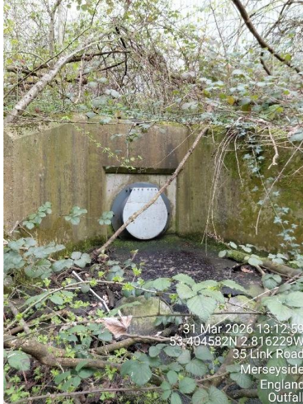
Photo 37: Outfall discharge (SJ 45832 90062)
