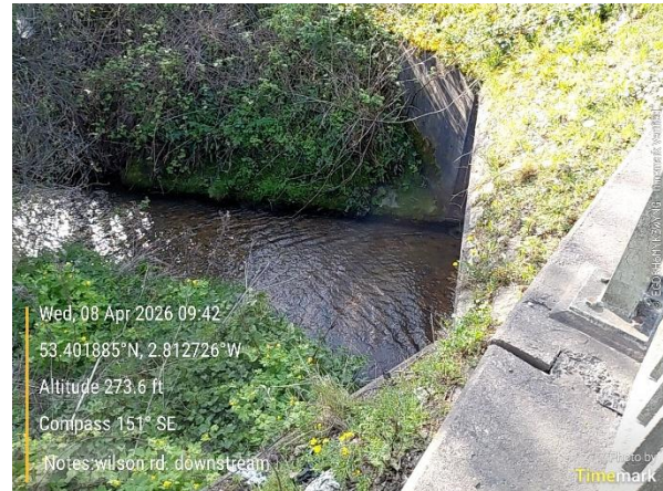
Photo 41: Downstream culvert (SJ 46062 89759)
