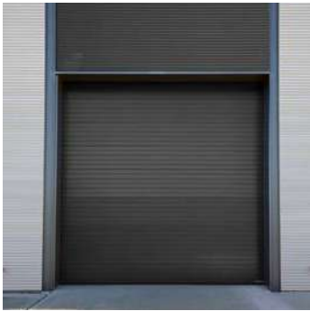
Level loading door
